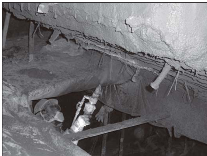
写真2 吹付け工法（補修部位：スラブ下面、作業方向：上向き）
