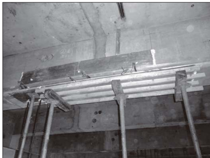
写真3 充てん工法（補修部位：梁、作業方向：横向き）
