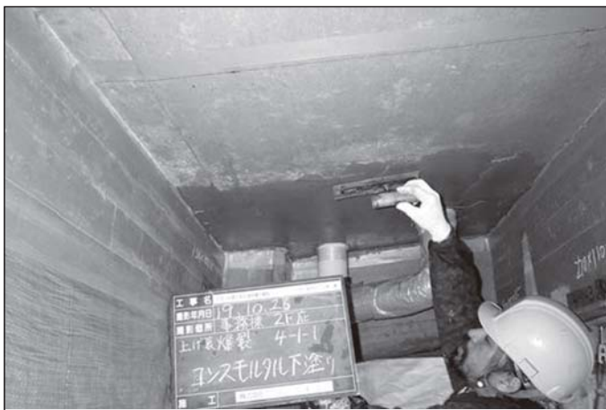
写真1 左官工法（補修部位：床スラブ下面、作業方向：上向き）
