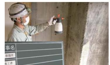
写真2 吸水防止材塗布状況
