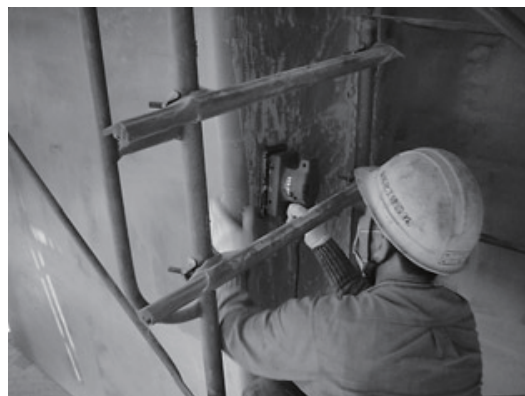
写真5. コンクリートカンナによる下地調整材のこてむら除去
