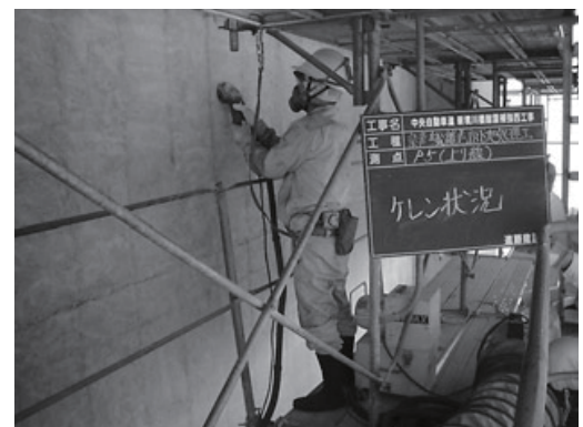
写真3. 研磨法による下地処理
