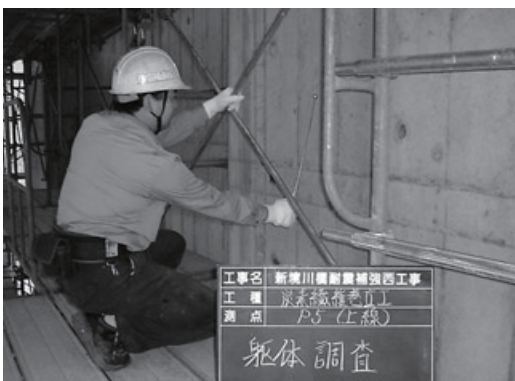
写真1. テストハンマーによる打音検査
