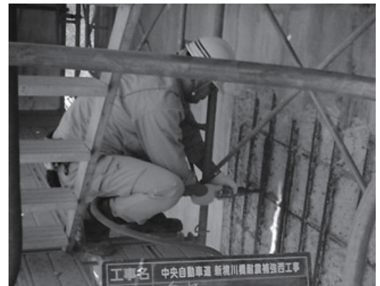
写真2. 鉄筋錆びの除去
