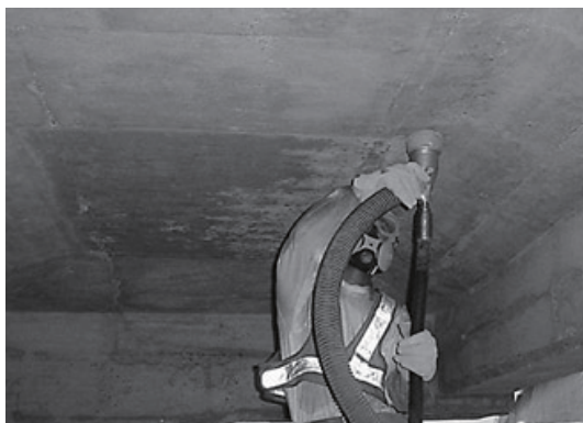
写真4. プラスト法による下地処理（油脂類の除去）
