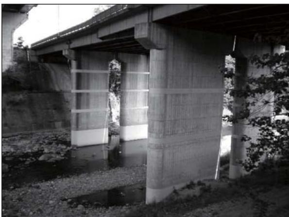
写真3 炭素繊維シートで補強した橋脚
