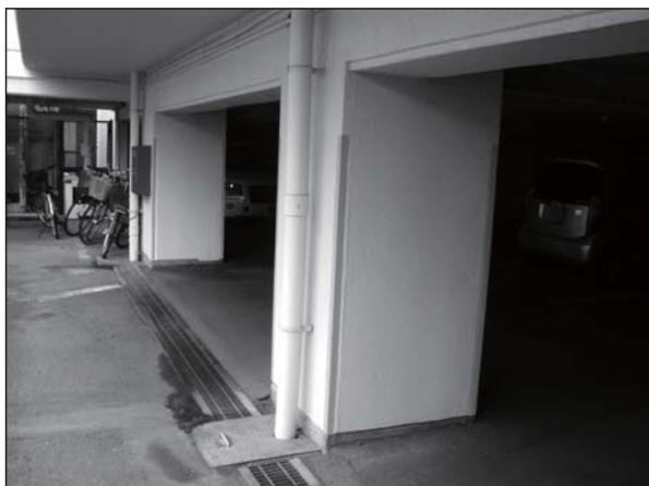
写真2 アラミド繊維シートで補強したマンションのピロティー柱
