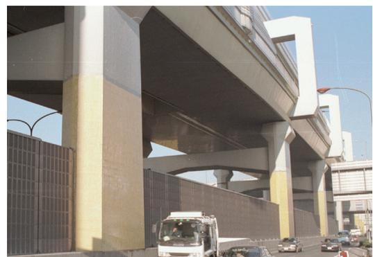
写真 2 道路橋脚の補強例
