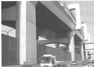
写真2 土木構造物施工例
