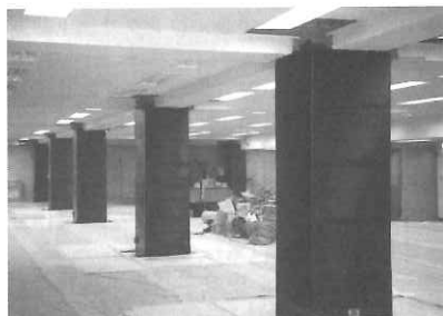
写真1 建築構造物施工例
