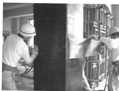
写真5 連続繊維シートの施工状況
