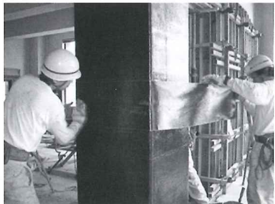
写真4 連続繊維シートの施工状況
