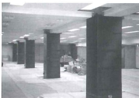
写真1 連続繊維補強施工例
